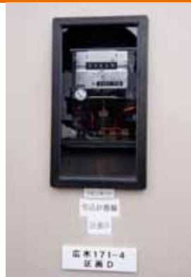
この計器で4m×20mパネル4枚分、畑面積で約500㎡の発電量を計測している。
